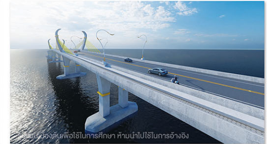
รูปแบบโครงสร้างสะพานช่วงหลักข้ามทะเลสาบสงขลา
